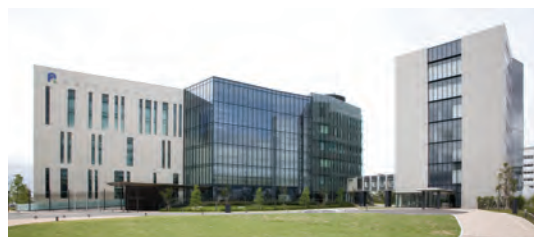
京速コンピュータ「京」施設(左)と 計算科学センタービル(右)
