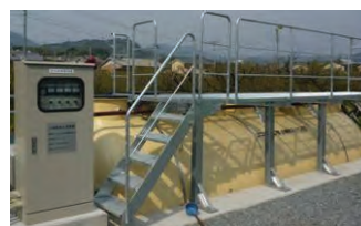
梅加工場に導入された 低コスト排水処理設備
