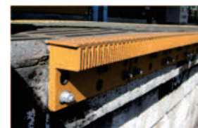
設置された隙間緩衝材
